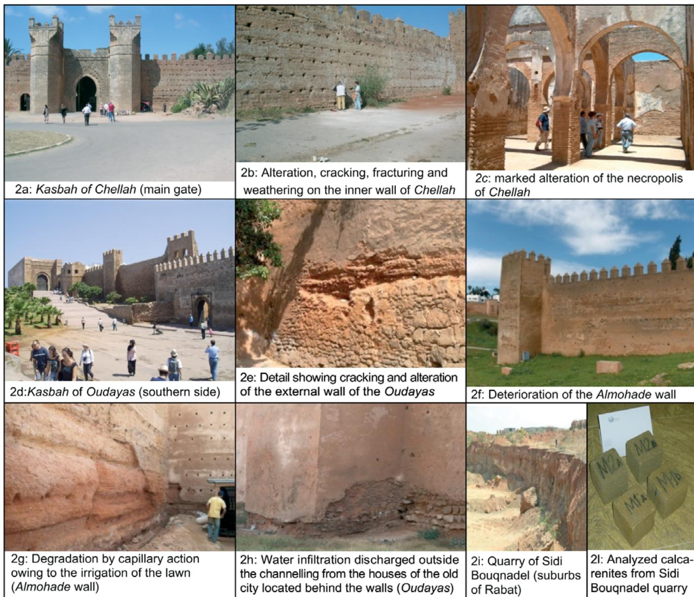
Fig. 2 - Widespread deterioration processes in the Kasbahs of Chellah and Oudayas and along the Almohade wall. - Diffusi processi di deterioramento nella Kasbah di Chellah, in quella degli Oudayas e lungo la muraglia Almohade.
